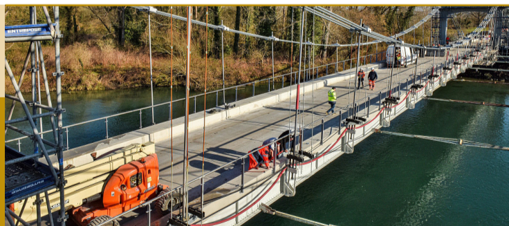
◀ Pont de Viellenave-de-Navarrenx
